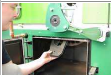
Посла замена пластинки держатель толкайте обратно на место, в зазоре между решеткой и боковую пластинку котла.
